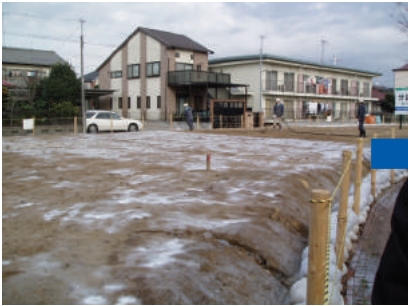
施工直後の状態
